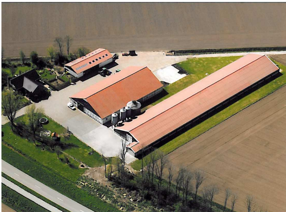
figuur 3.1.2: Luchtfoto huidige situatie Colijnweg 4 (uit privé-collectie maatschap Kerremans)
