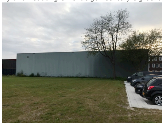
Zijde opslagplaats aangrenzende parkeerplaats nieuwbouw
