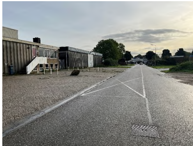
Foto 17: overzicht foto 6 asfalt
