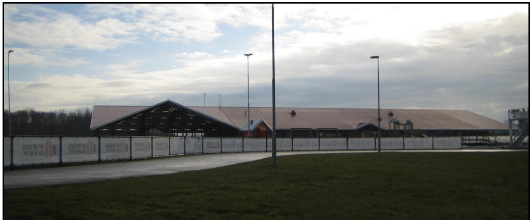
Foto entreegebouw Flevonice (bron: veldbezoek SAB 14 januari 2014)
