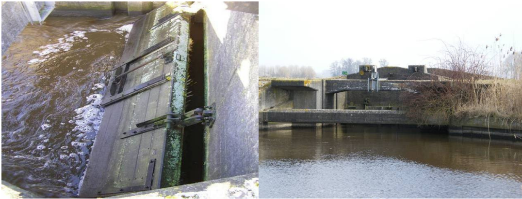
Afbeelding 4.23. De Doornse Sluis
