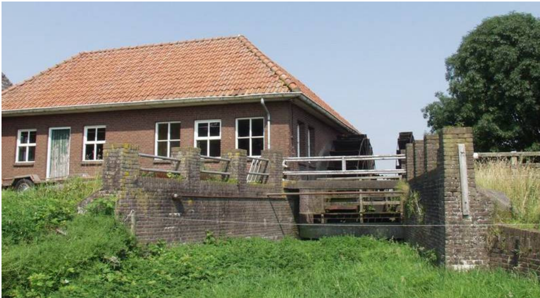
Afbeelding 4.20. Gemaal aan de Flevoweg 74 te Kampen
