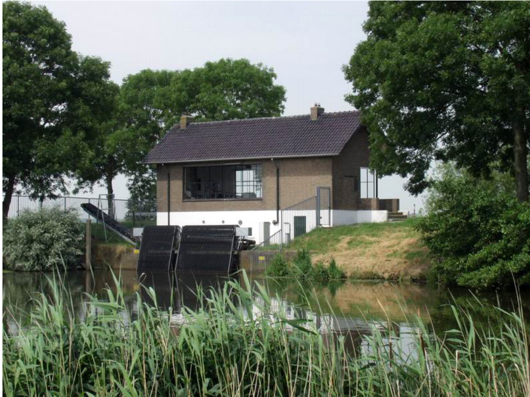
Afbeelding 4.17. Gemaal aan de Noordwendigedijk 12a
