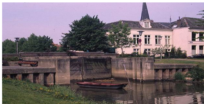
Afbeelding 4.24. Sluis in de La Sablonierekade te Kampen
