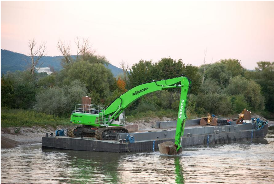
Figuur 2-14: Kraan voor ontgraven en afvoeren van steenbestorting en grond
