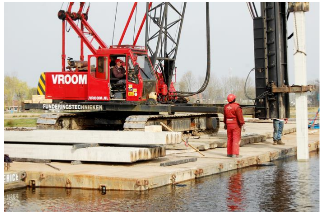
Figuur 2-11: Heistelling op ponton
