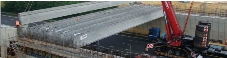
Figuur 2-13: Inhijsen betonnen liggers
