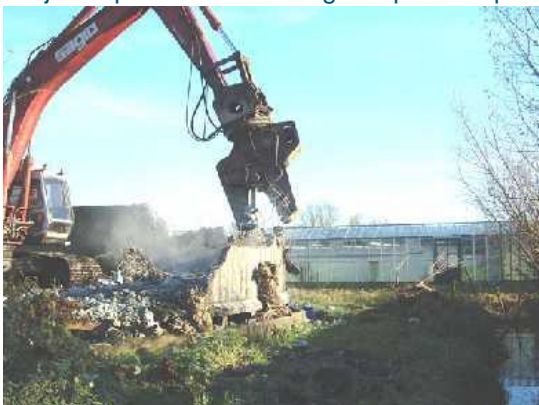
Figuur 2-18: Materieel sloop: kraan met hydraulische knijper
