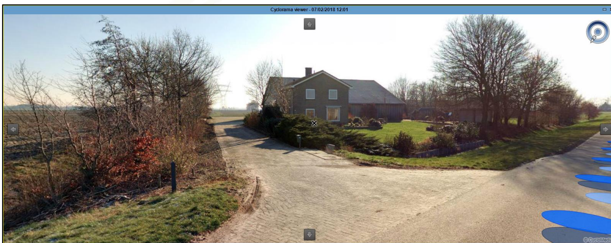
Figuur 11: foto vanaf de weg met zicht op de woning en akkerbouwbewaarloods. (Bron: Cyclomedia)
