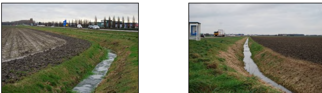
Afbeelding 3.3 Beeld van de wegberm en bermsloot (jan. 2014).
