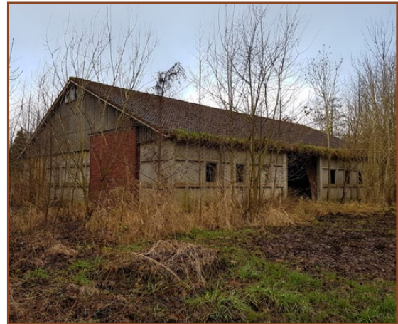
Afb. 2.2: Dezelfde schuur, gezien vanuit zuidoostelijke hoek. Aan de oostkant zijn de goten volledig dichtgegroeid met grassen en boompjes.
