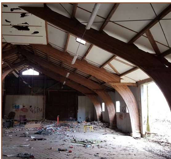
Afb. 2.5: Binnenkant schuur. Door vandalisme en gebrek aan onderhoud is het pand sterk vervallen. Duidelijk te zien zijn de grote hoeveelheden afval.
