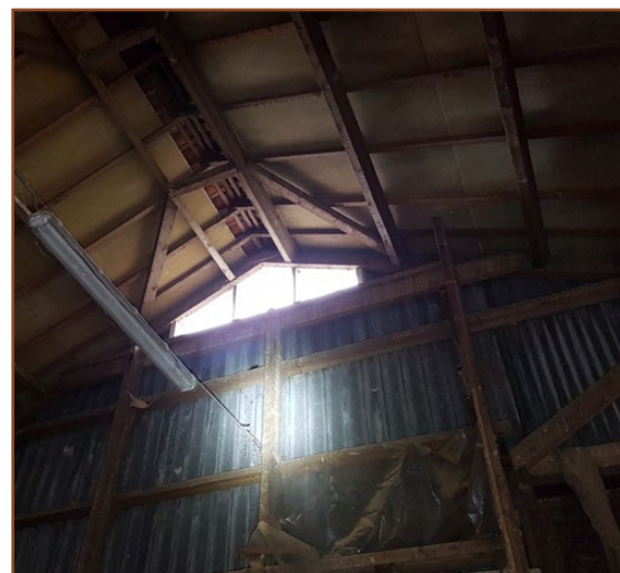
Afb. 2.6: Binnenzijde kopgevel met de enkellaags golfplaten afwerking.
