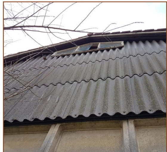
Afb. 2.4: Detail buitenzijde kopgevel. Vleermuizen hebben toegang tot de ruimte tussen pannen en dakbeschoot en tot de ruimte achter boeidelen.
