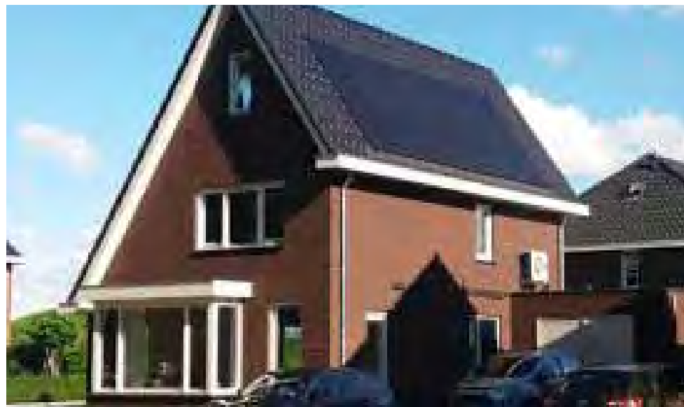
Voorbeeld van Indak" zonnepanelen op zuidzijde
