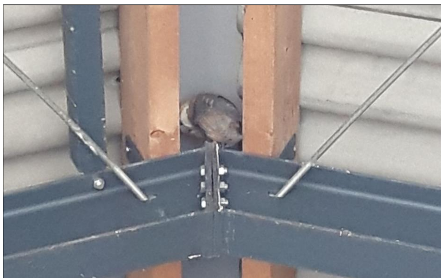
Figuur 1. Rustende kerkuil op een spant aan de binnenzijde van de oostelijke loods op het erf.
