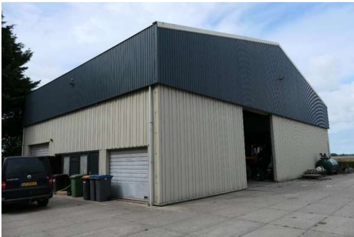
Figuur 1.3 De schuur, gezien vanuit het oosten.
