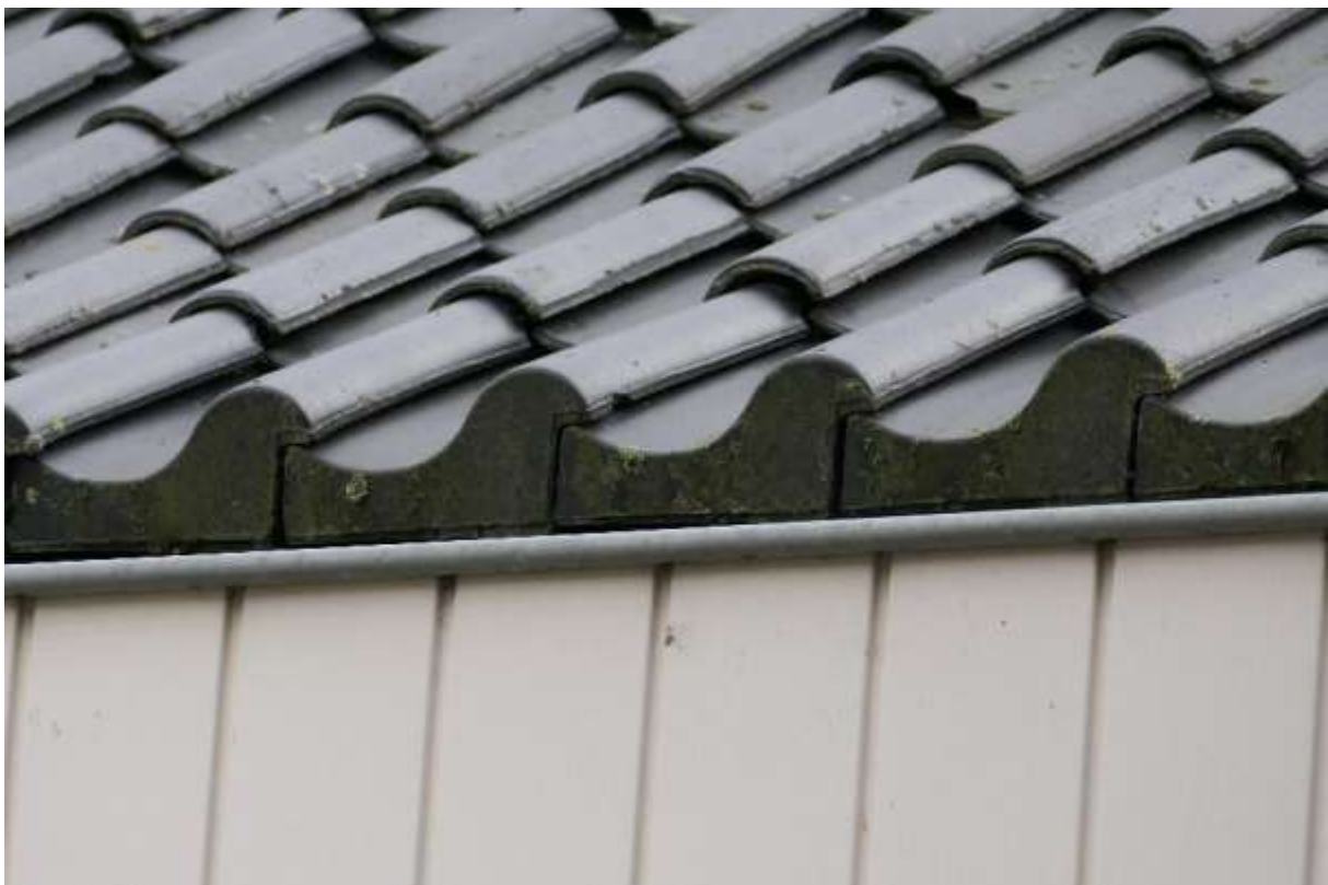
Figuur 4.2 De eerste rij dakpannen van het huis zijn afgesloten.
