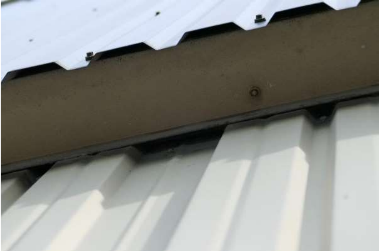
Figuur 4.3 Tussen de golfplatengevels schuur zijn openingen aanwezig.
