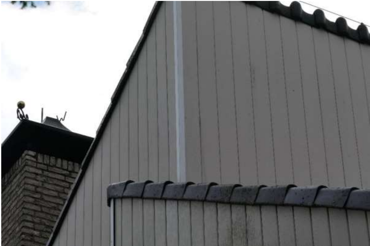
Figuur 4.1 De kantpannen van de woning sluiten goed aan op de gevel.
