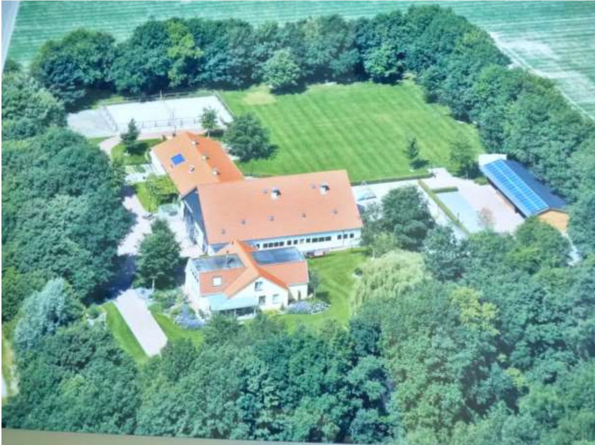
Figuur 4: Luchtfoto Reveweg 8
