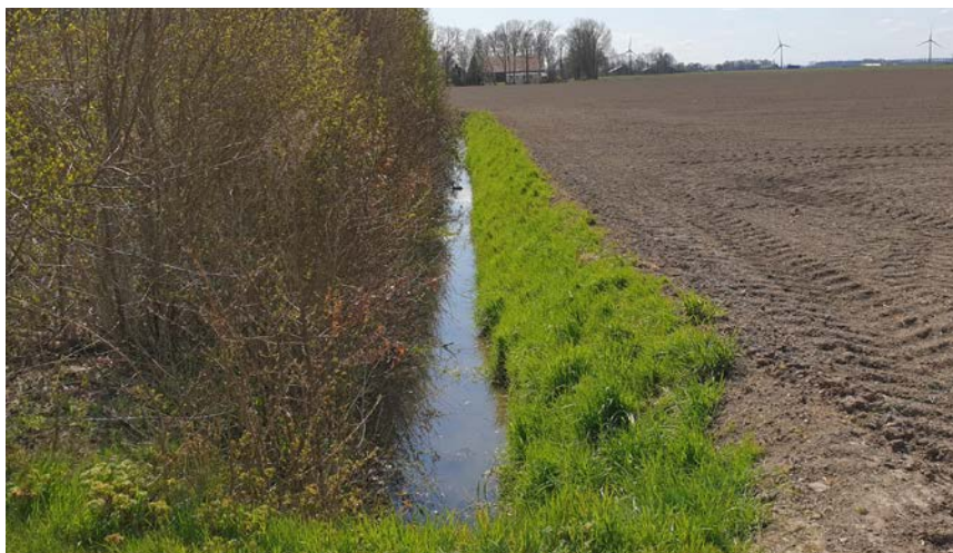
Sloot richting zuiden achter erf Bisonweg 4
