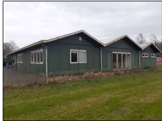
Afbeelding 2.3. Houten bebouwing, achterkant.
